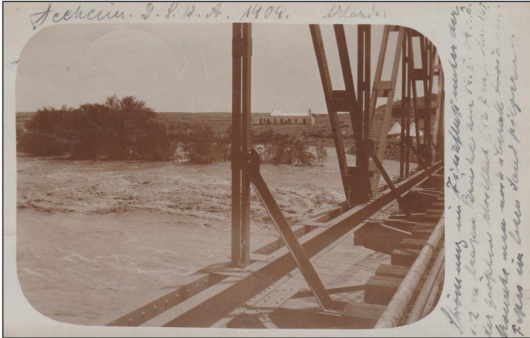
Fotokarte der Eisenbahnbrücke mit Blick aus dem Zug auf den Fischfluss an:
